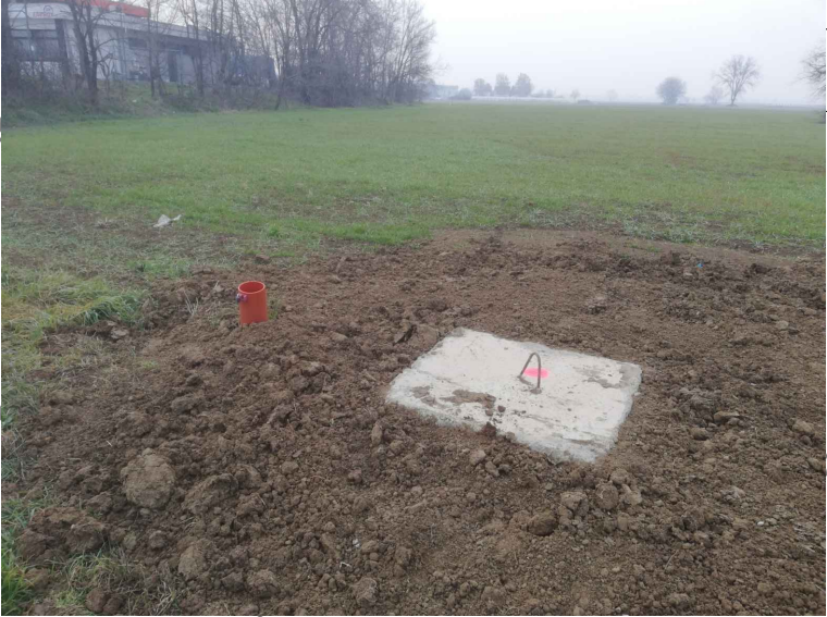
Borchia in acciaio su manufatto in CLS
