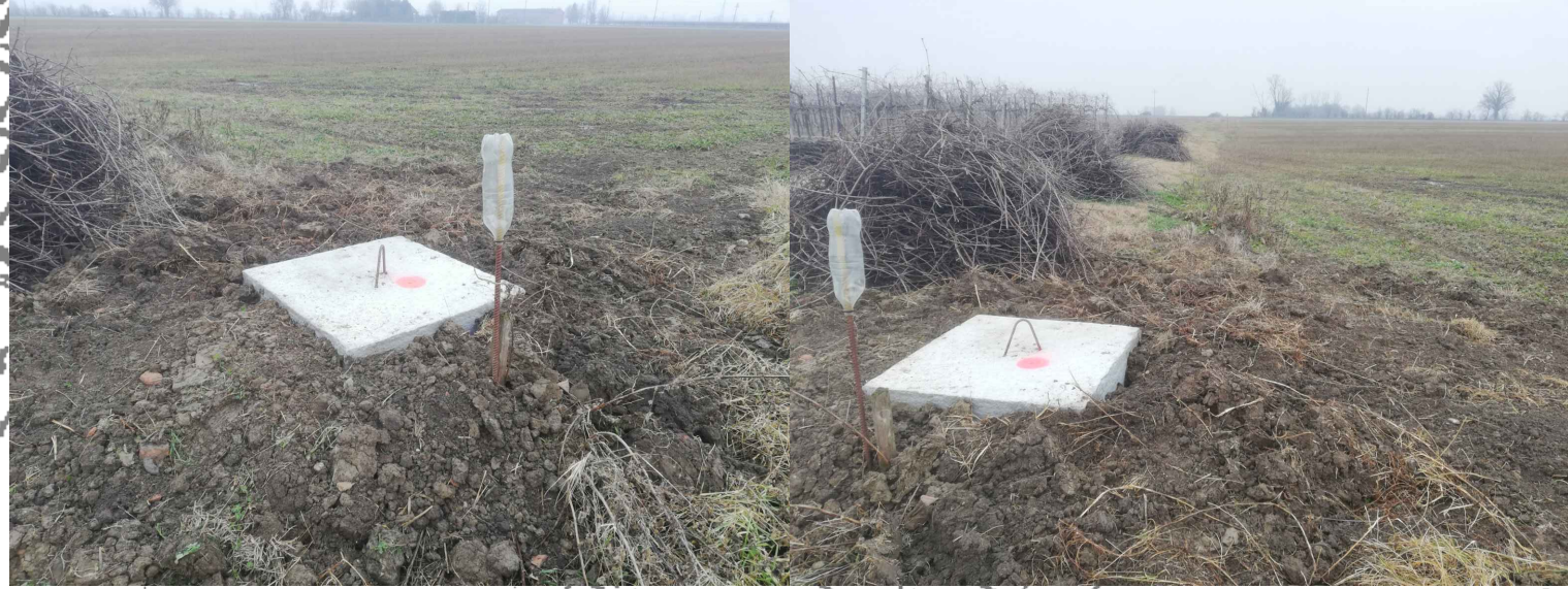
CPS 04 E=1619043.39 N=4957366.22 Z=41.77 Borchia in acciaio su manufatto in CLS
