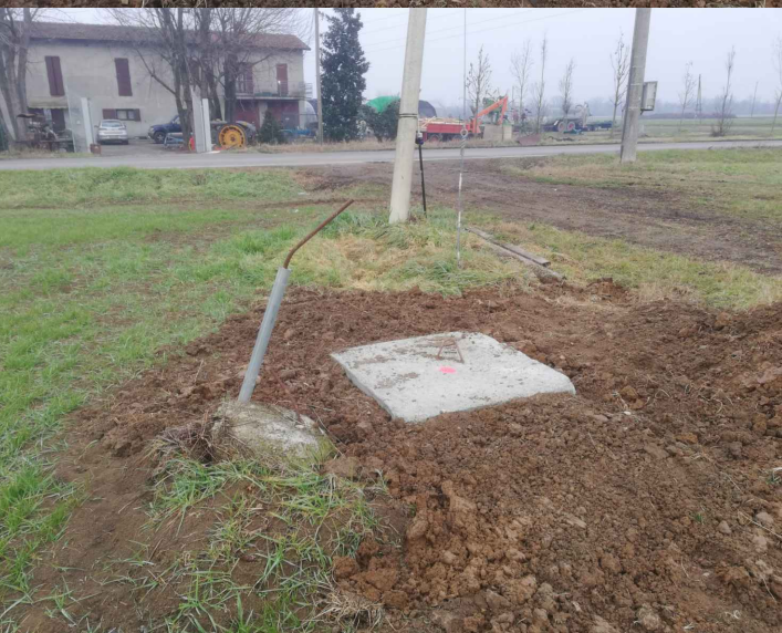
CPS 01 E=1618604.84 N=4956857.89 Z=45.70 Borchia in acciaio su manufatto in CLS
