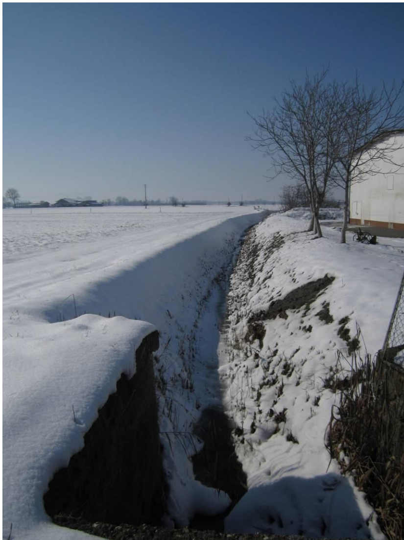
Figura 13 – Vista del cavo Fontana in direzione dei Comuni di Gattatico e di Sant'Ilario.
