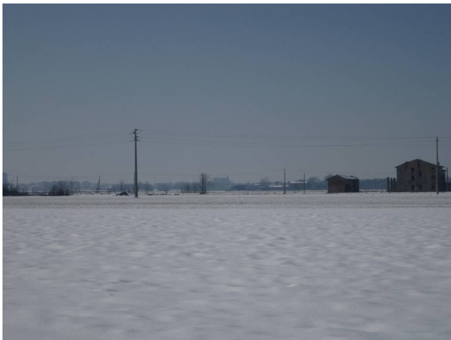
Figura 9 – Vista degli elettrodotti MT che attraversano la porzione di comparto ubicata a sud della S.P. 39.
