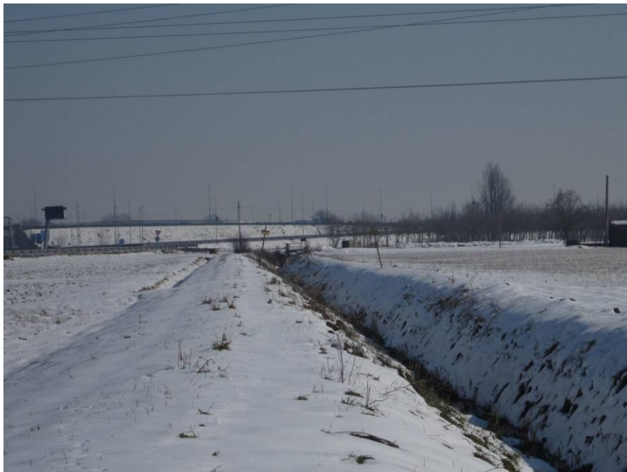
Figura 17 – Vista del raccordo autostradale e di una parte del casello.
