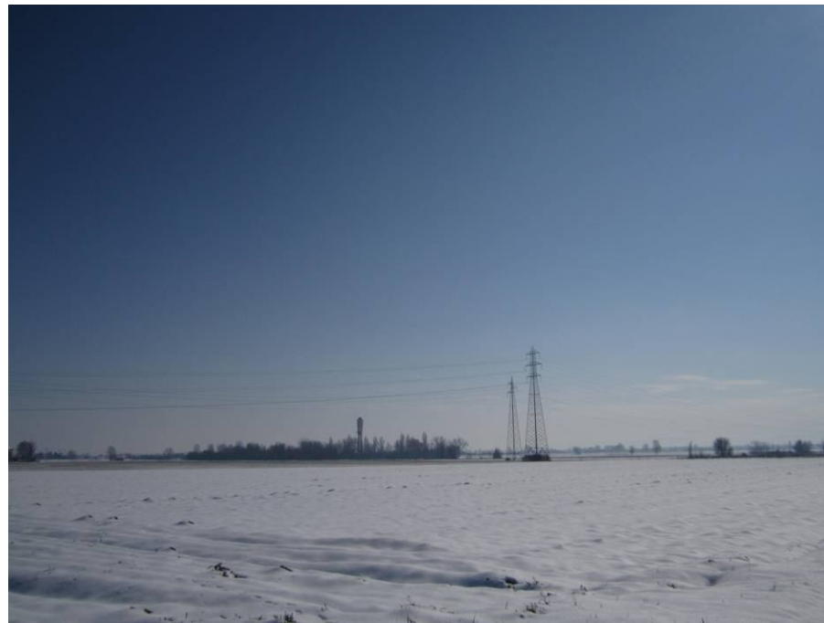
Figura 18 – Vista degli elettrodotti AT e della zona della centrale idrica ubicati a sud dell'area di progetto.
